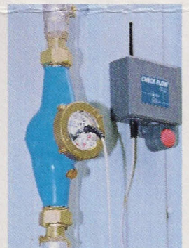
Le disjoncteur hydraulique évolue vers une fonction à communication de défaut.
